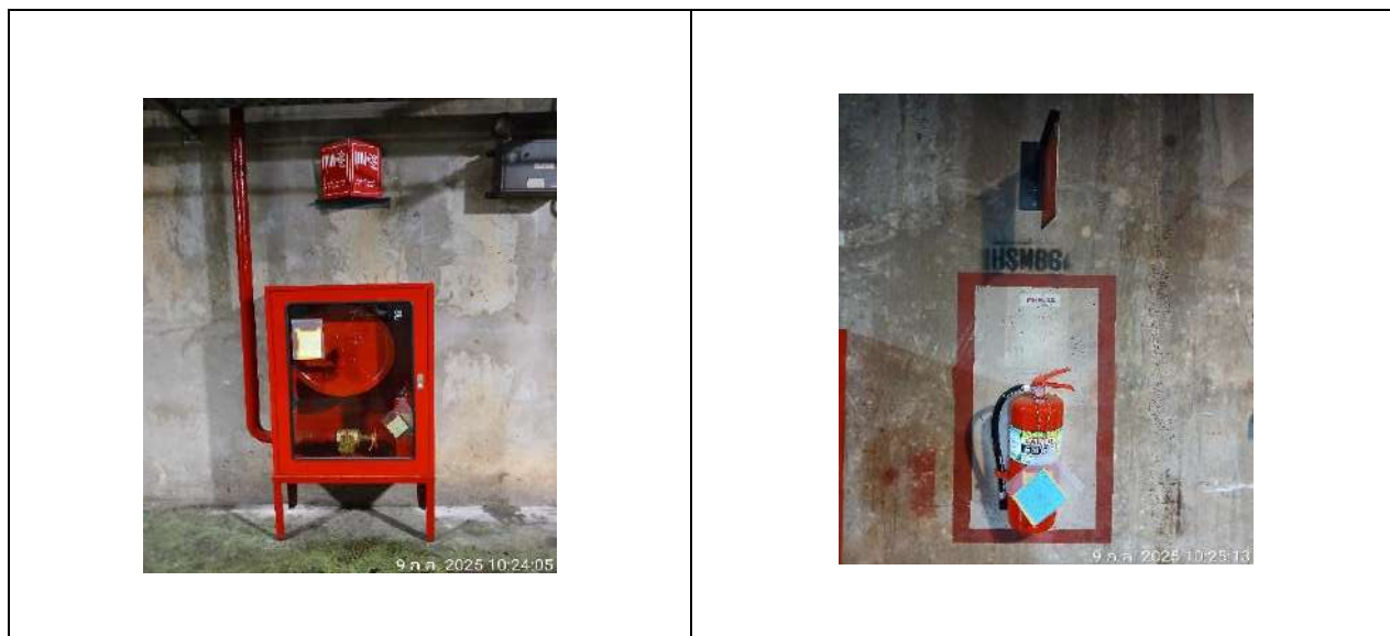
ภาพที่ 30 การติดตั้งอุปกรณ์ระบบดับเพลิงที่ได้มาตรฐาน
