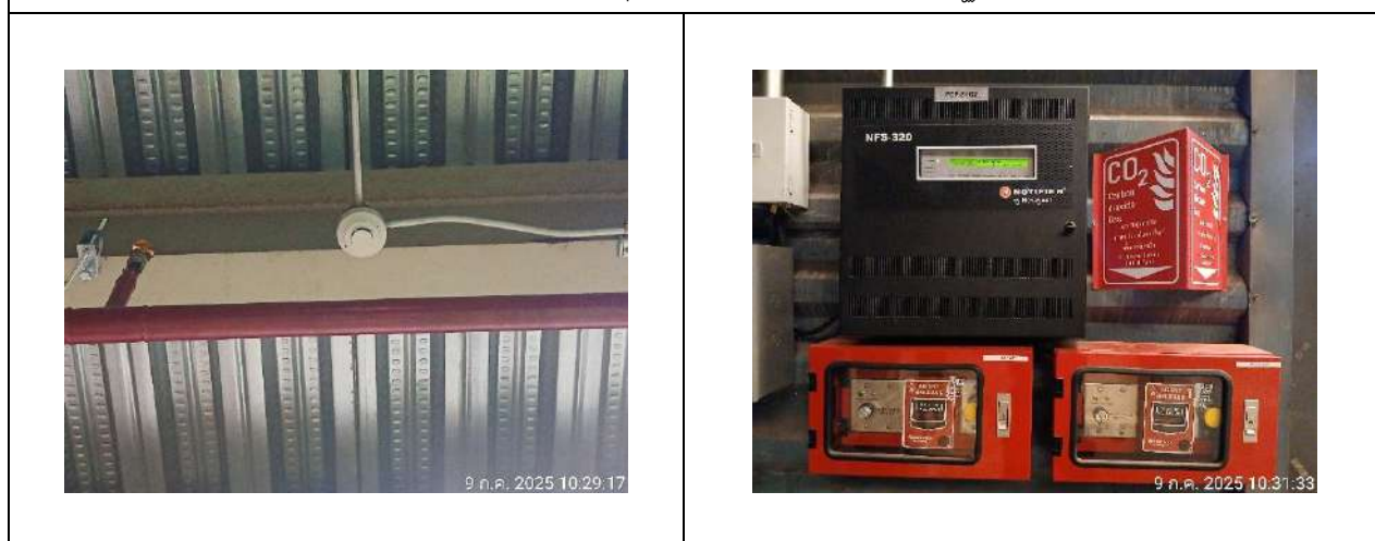
ภาพที่ 30 การติดตั้งอุปกรณ์ระบบดับเพลิงที่ได้มาตรฐาน
